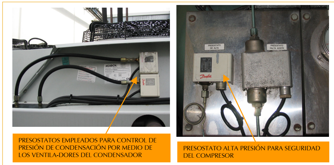
Fig. 44: Ejemplos de aplicación de presostatos.
