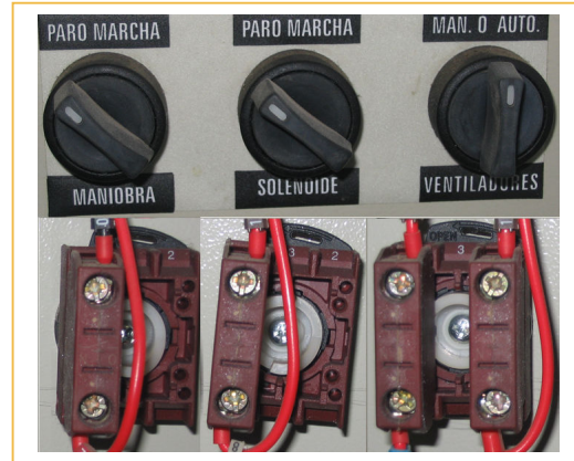
Fig. 41: Interruptores de dos y tres posiciones (vista frontal arriba y posterior debajo).
