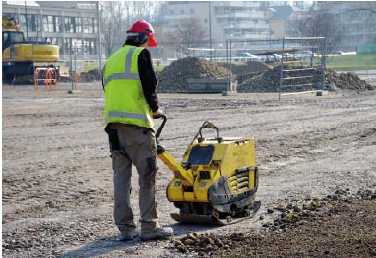
Figura 2.33. Compactadora con bandeja.
