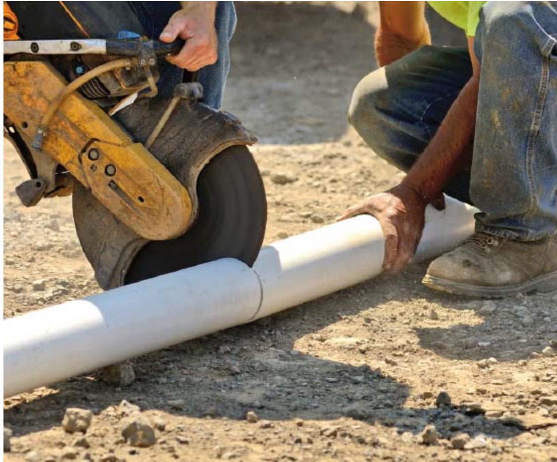
Figura 2.31. Sierra circular cortando tubo.
