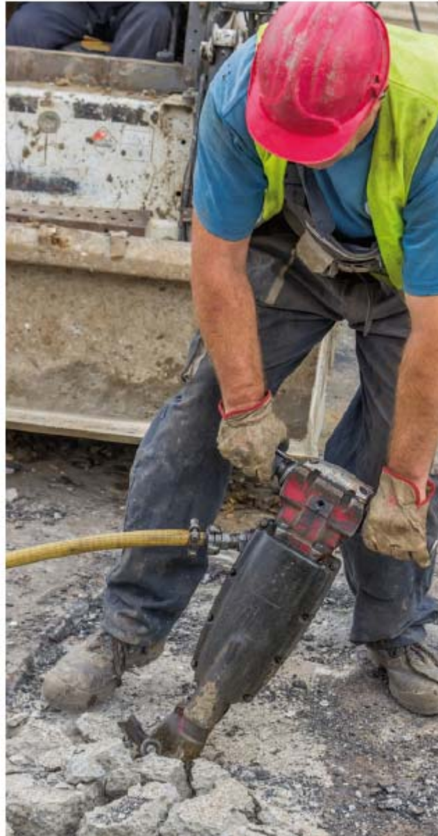
Figura 2.34. Martillo neumático.
