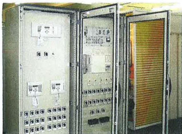
Figura 4.23. Cuadro de tipo cerrado, para acceder a su interior hay que retirar tapas.
