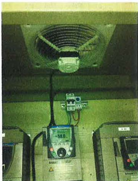
Figura 4.76. Ventilador en la parte superior de un cuadro eléctrico.
