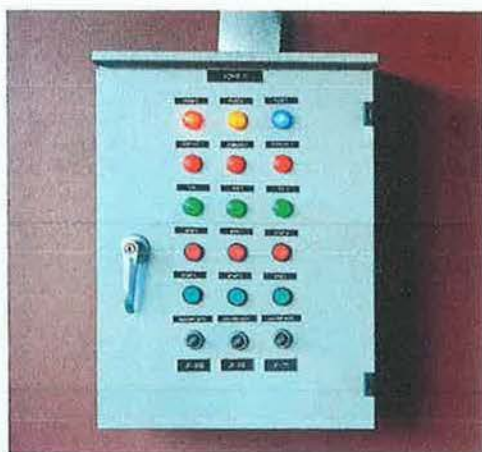
Figura 4.21. Cuadro de maniobra de un automatismo industrial fijo en superficie o fijación mural.
