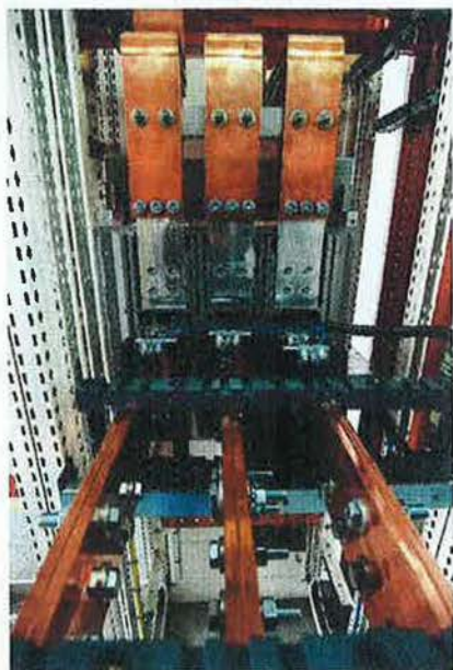
Figura 4.51. Embarrado conectado a un interruptor general.
