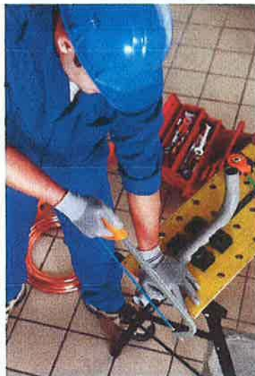
Figura 5.38. Corte de un tubo de plástico para canalización eléctrica con sierra de arco.
