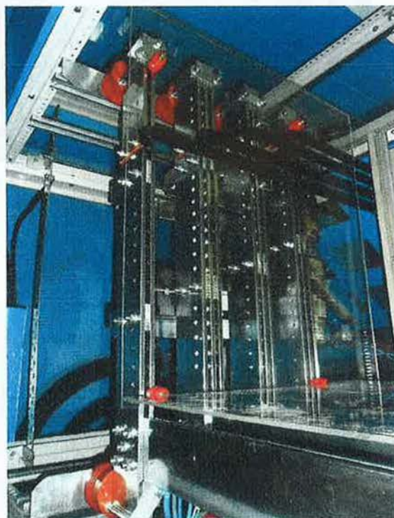
Figura 5.76. Cuadro con embarrado de cobre cadmiado.
