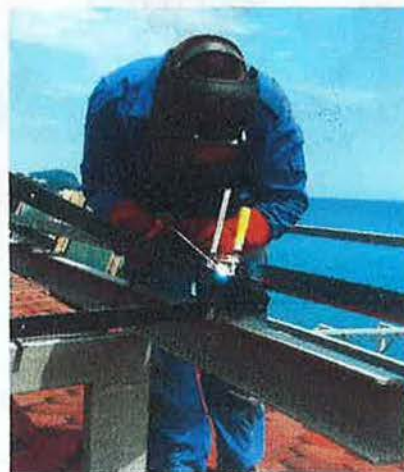
Figura 5.70. Soldadura de perfiles por arco eléctrico.
