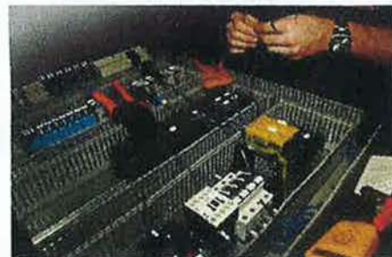
Figura 5.99. Detalle de cableado interior de una canaleta una vez ubicadas las posiciones de estas y de la aparamenta.
