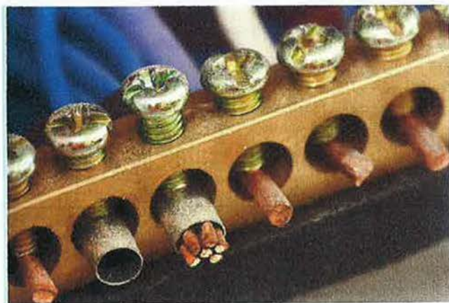
Figura 4.74. Detalle en el que se observa la diferencia de la superficie de contacto en uniones roscadas con y sin punteras.
