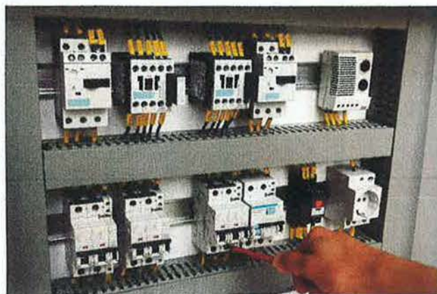
Figura 5.67. Apriete con destornillador de los bornes de la aparamenta.
