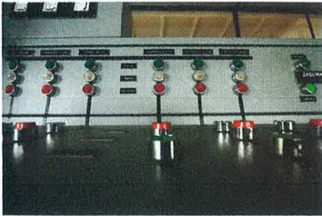
Figura 4.18. Cuadro de control para automatismos de tipo pupitre.
