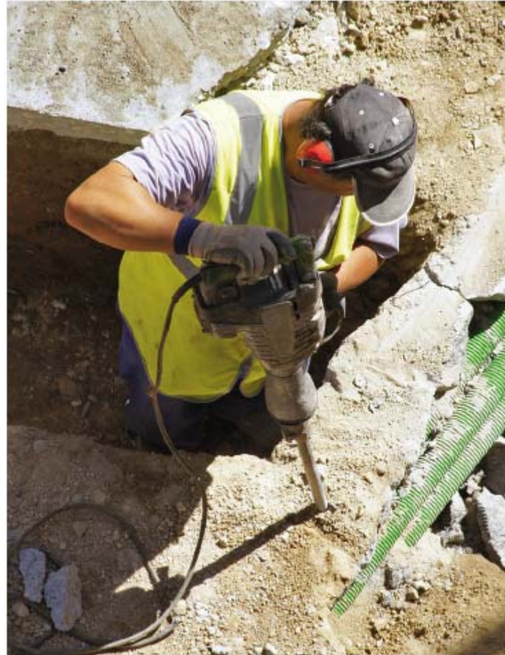
Figura 9.2. Trabajos a distinta altura con posibilidad de atrapamiento.
