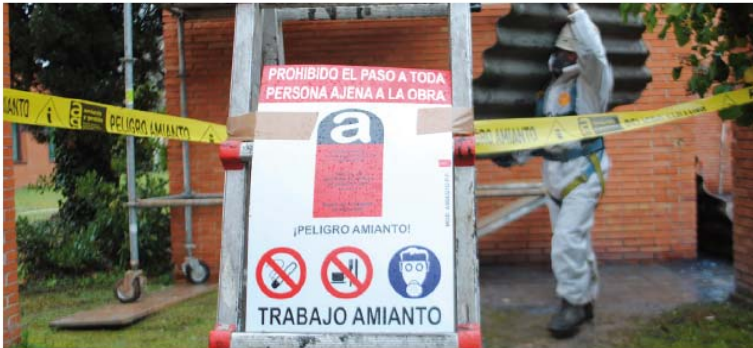
Figura 9.25. Traslado de piezas con amianto por especialistas.
