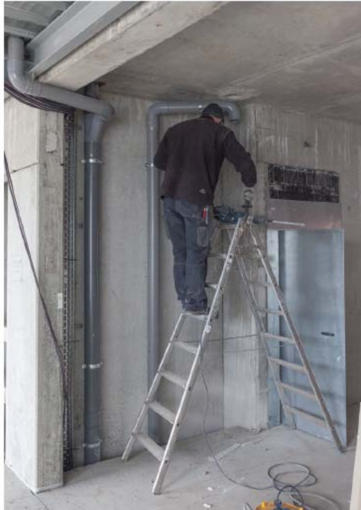
Figura 9.1. Instalación de una bajante con una escalera de mano.
