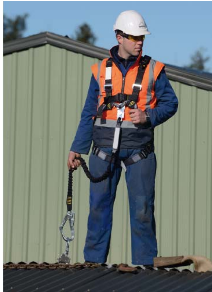
Figura 9.17. Trabajos en altura con arnés de seguridad.
