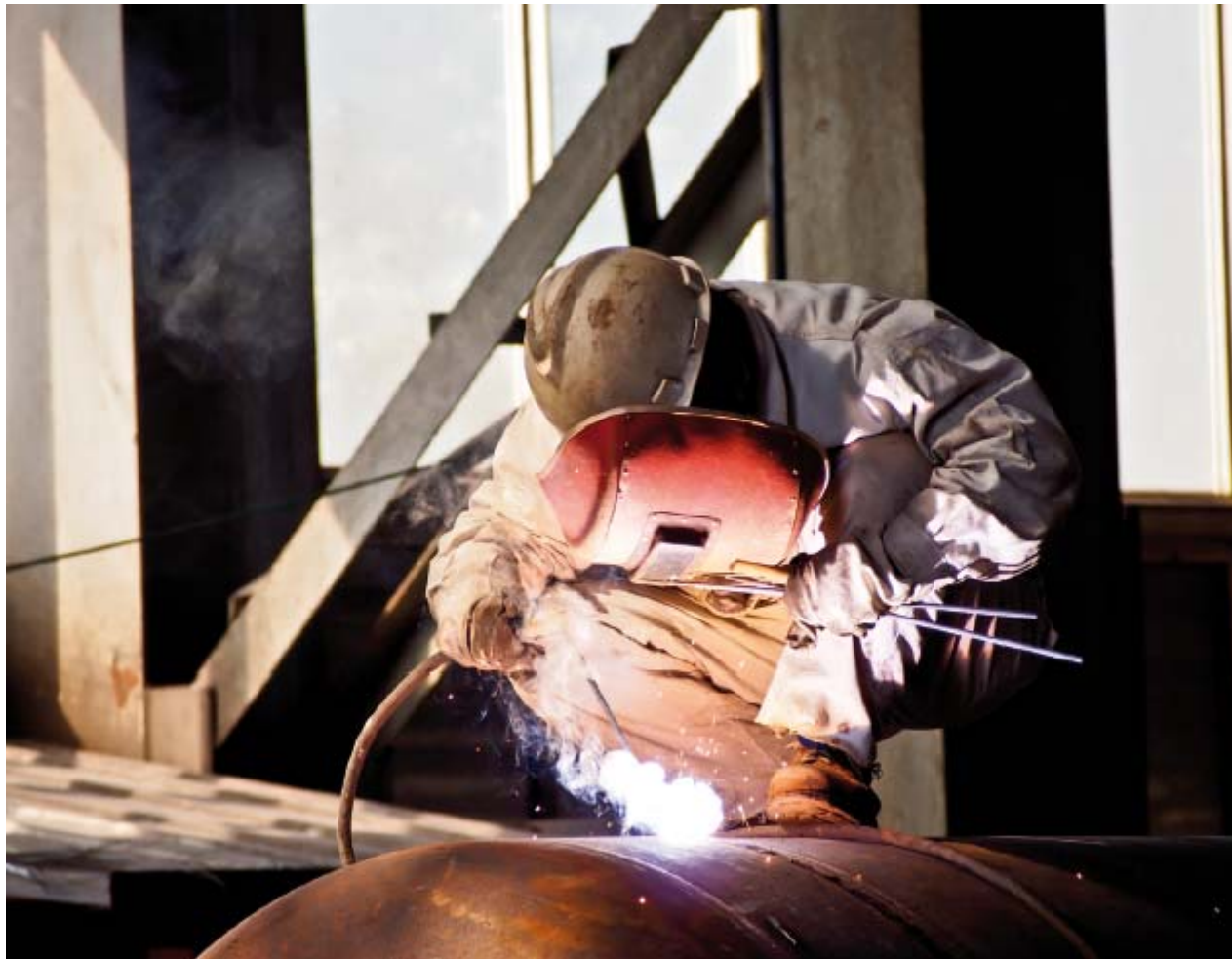
Figura 9.5. Soldadura en un espacio amplio y con traje específico.
