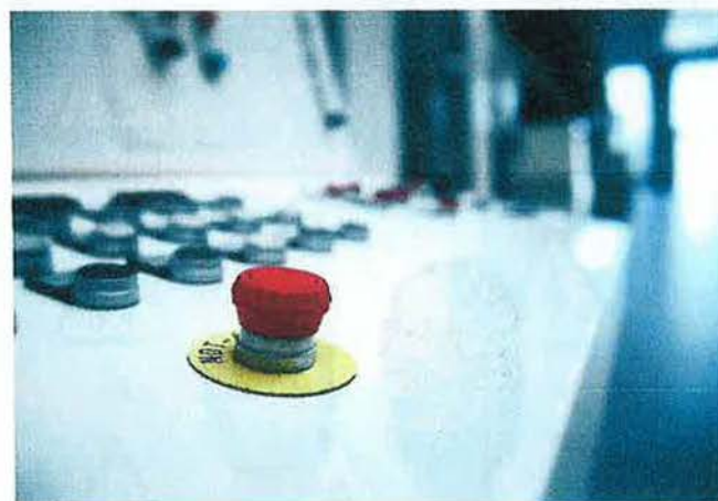
Figura 13.27. Pulsador de paro de emergencia integrado en un cuadro de control industrial.
