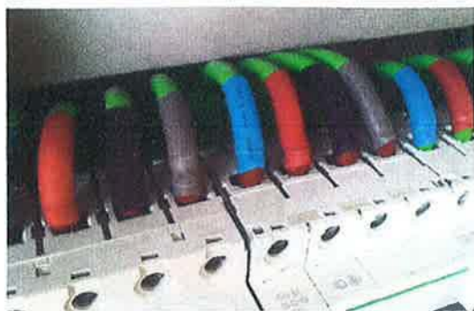
Figura 12.22. Detalle del marcado manual de colores de las mangueras cuando no cumplen el código establecido.
