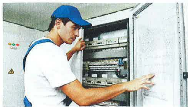
Figura 12.25. La verificación de los esquemas unifilares asociados a un cuadro eléctrico es una tarea de mantenimiento preventivo.
