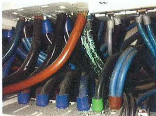
Figura 12.18. Las sobrecargas en los circuitos eléctricos, así como los malos aprietes de tornillería, son una fuente de averías que generan el sobrecalentamiento y destrucción de los conductores.
