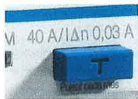
Figura 12.24. Detalle del pulsador de test de un interruptor diferencial doméstico.
