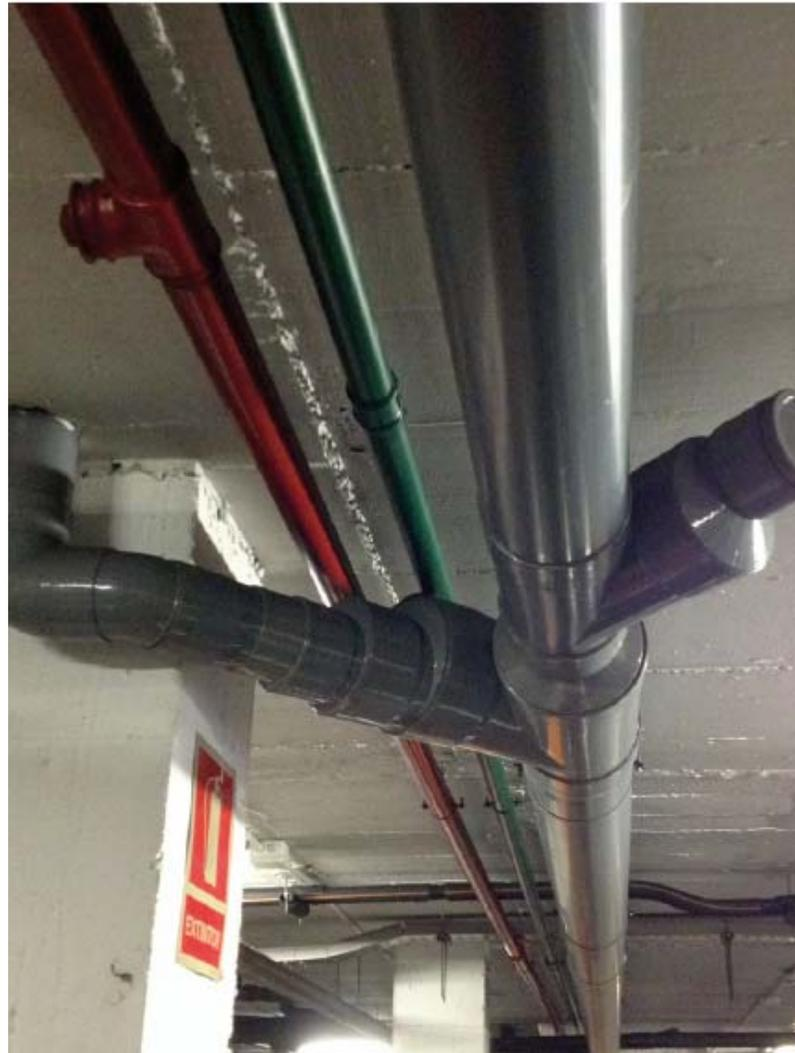
**Figura 6.9.** Conexión de bajante a un colector suspendido con tapa de registro.
