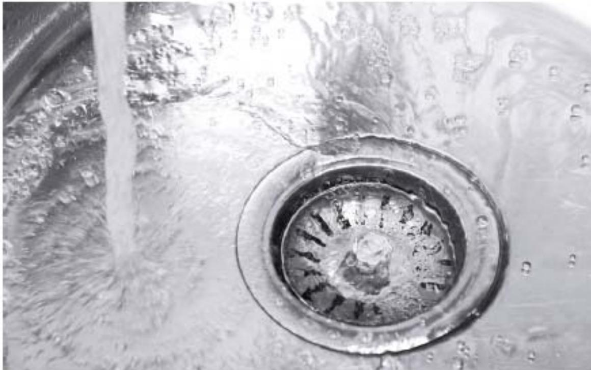
Figura 6.2. Válvula de desagüe.
