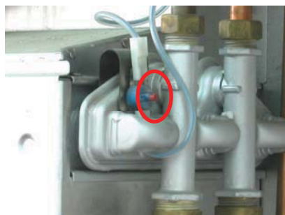
Figura 21. – Botón de rearme del termostato
