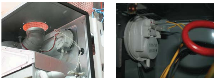
Figura 30.- Situación del presostato diferencial
