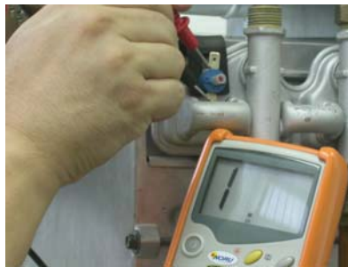
Figura 20 – Comprobación de contactos
