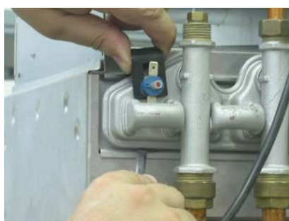
Figura 23– Sustitución termostato de seguridad
