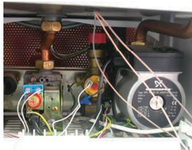
Figura 26 – Situación de la bomba circuladora.
