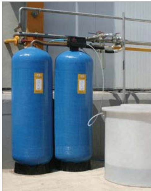
Descacificador instalado
