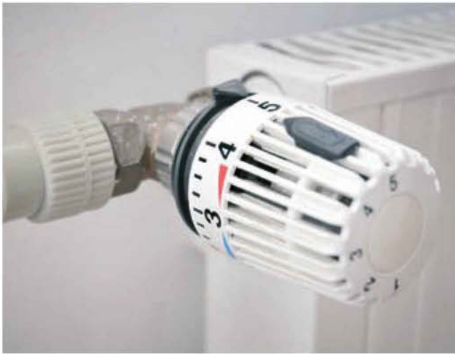
Figura 10.22. Válvula termostática de un radiador
