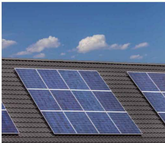
Figura 11.21. Captadores planos sobre cubierta
