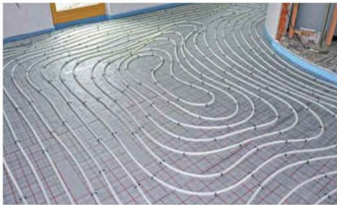
Figura 10.20. Instalación de suelo radiante
