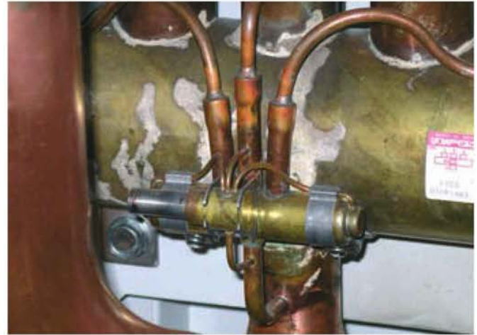
Figura 7.10. Válvula de cuatro vías
