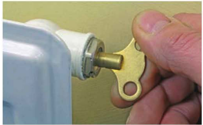
Figura 10.18. Purgadores manuales de radiador
