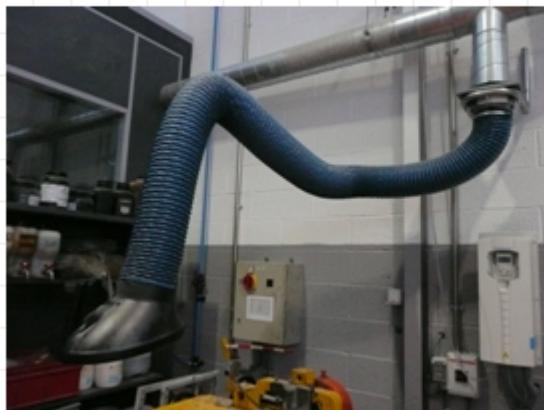
Cualquier equipo de trabajo que entrañe riesgo por emanación de gases, vapores o líquidos o por emisión de polvo deberá estar provisto de dispositivos adecuados de captación o extracción cerca de la fuente emisora correspondiente. Por medio de este ejercicio vamos a tratar de profundizar en este aspecto.
