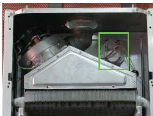
Figura 13.29 – Situación del presostato diferencial de aire.
