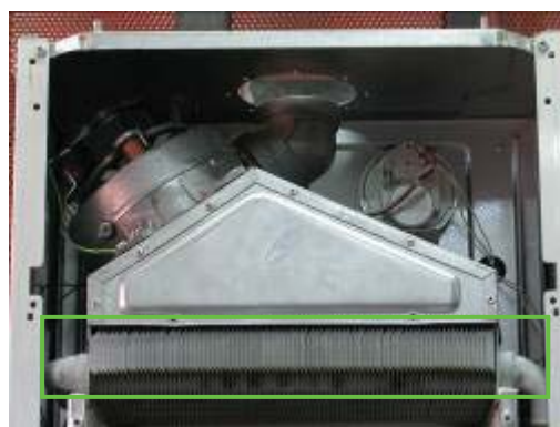
Figura 13.11 – Situación del intercambiador de calor.
