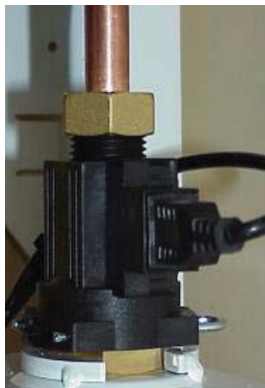
Figura 13.36 – Detector de ACS tipo flotador.
