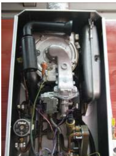
Figura 13.47 – Caldera de condensación.
