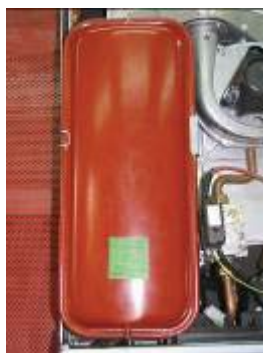
Figura 13.47 – Vaso de expansión de una caldera de condensación.
