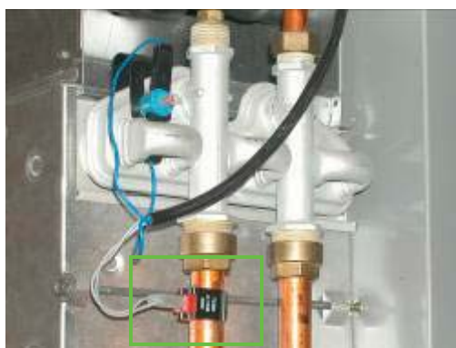
Figura 13.17 – Sensor de temperatura de calefacción.
