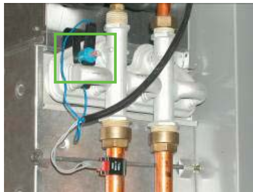
Figura 13.23 – Situación del termostato de seguridad.
