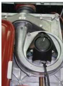
Figura 13.48 – Ventilador de una caldera de condensación.
