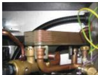
Figura 13.47 – Intercambiador de una caldera de condensación.
