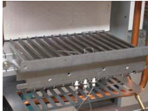
Figura 13.31 – Situación del electrodo de encendido.
