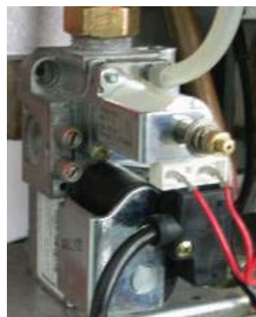
Figura 13.5 – Válvula de gas HONEYWELL.
