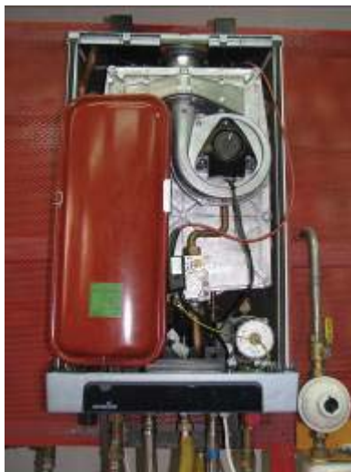
Figura 13.46 – Caldera de condensación.
