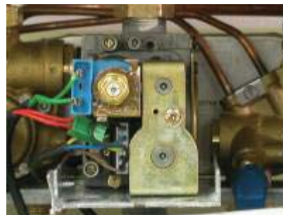
Figura 13.4 – Válvula de gas instalada.
