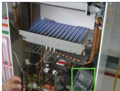
Figura 13.27 – Comprobación de sonda de ionización.
