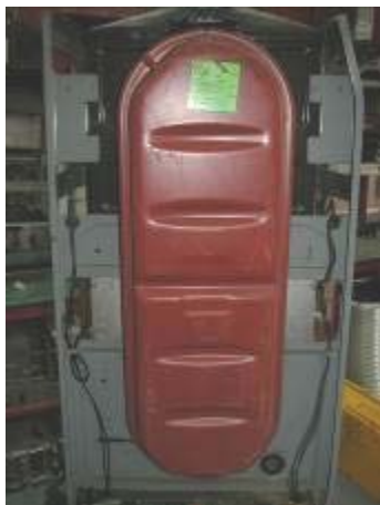
Figura 13.18 – Vaso de expansión de la caldera.
