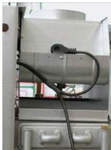
Figura 13.25 – Situación de sonda antidesbordamiento de PdC.
