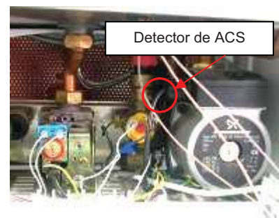
Figura 13.42 – Situación del detector de ACS.
