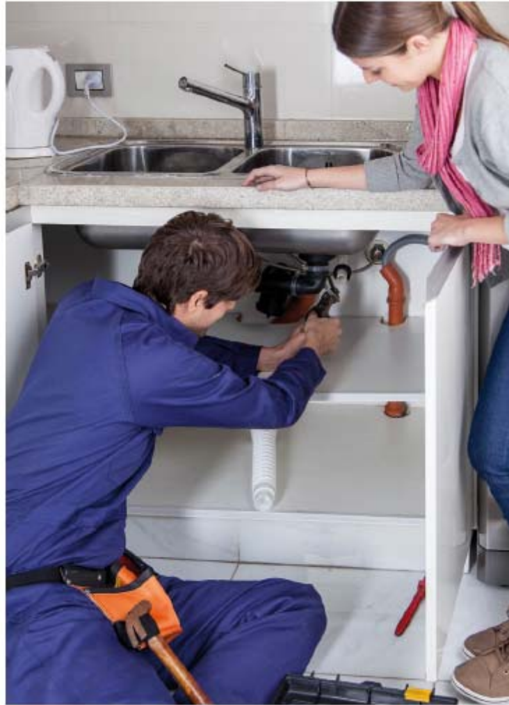
Figura 8.5. Revisión del sifón.
