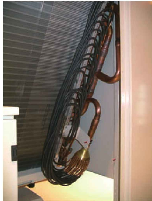
Figura 7.1. Evaporador
