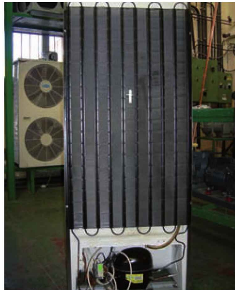
Figura 7.13. Condensador de frigorífico doméstico
