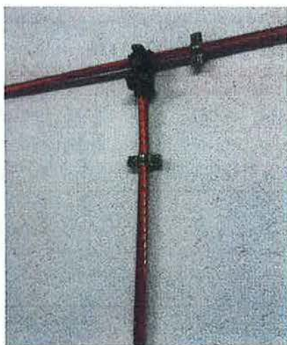
Figura 2.5. Conductor de cobre desnudo perteneciente a una toma de tierra.
