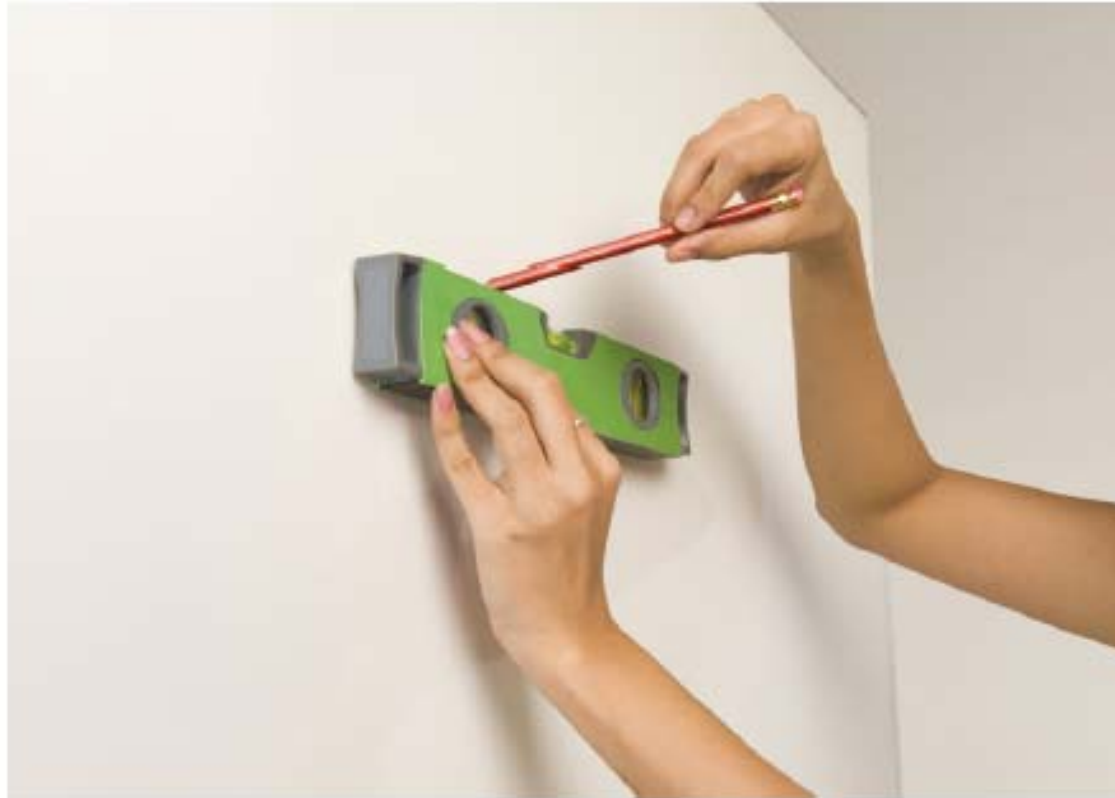
Figura 1.18. El nivel marca la línea horizontal con la burbuja centrada.
