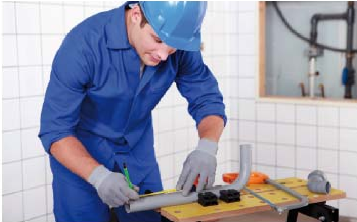
Figura 1.3. Medición de una tubería de PVC.
