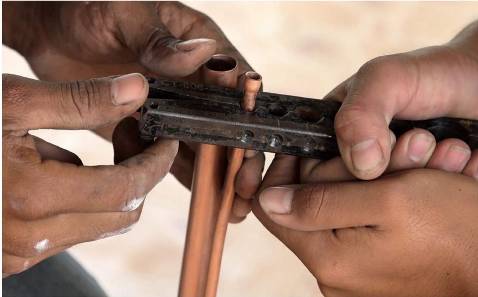
Figura 5.37. Ensanchado de tuberías de climatización.
