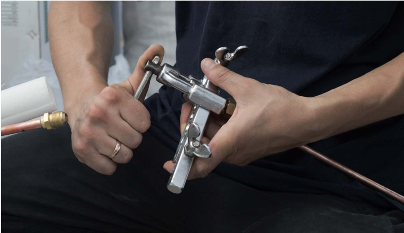
Figura 5.40. Operación de abocardado de tuberías de cobre.
