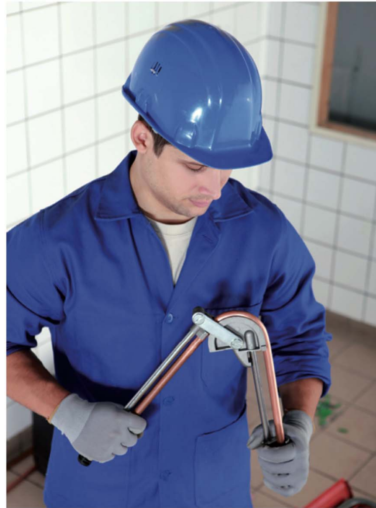
Figura 5.34. Curvado manual de tubería de cobre.
