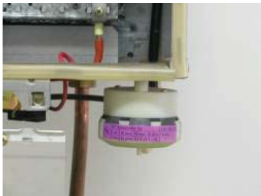
Figura 12.27 – Presostato diferencial de aire.
