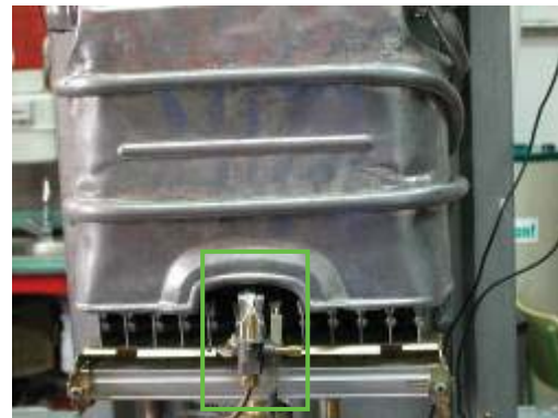
Figura 12.21 – Vista lateral del cortatiroso.
