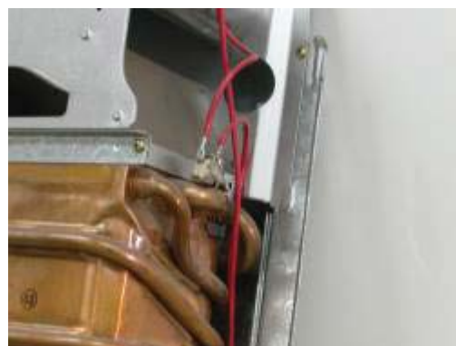
Figura 12.24 – Termostato de seguridad.
