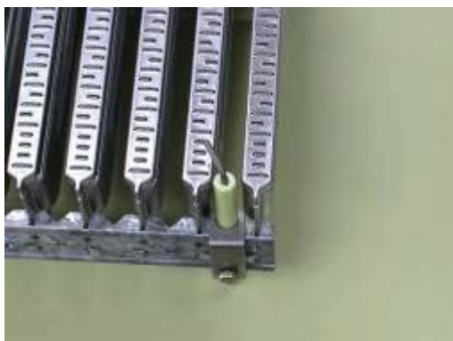
Figura 12.25 – Detalle de sonda de ionización.
