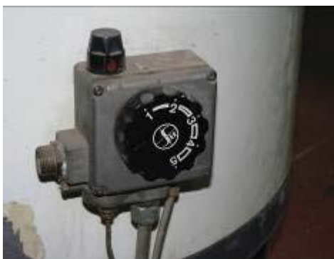
Figura 12.34 – Dispositivos de encendido
