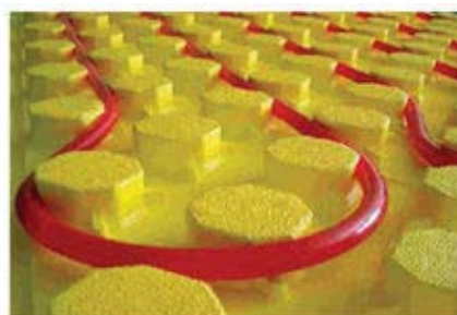
DETALES MONTAJE DE TUBOS CON PANEL AISLANTE MOLDEADO
