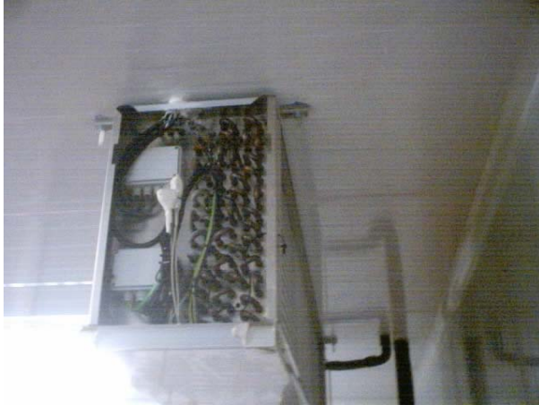
Evaporador con resistencias de desescarche
