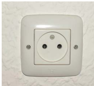
Figura 18 – Vista exterior de base de enchufe sin toma de tierra.
