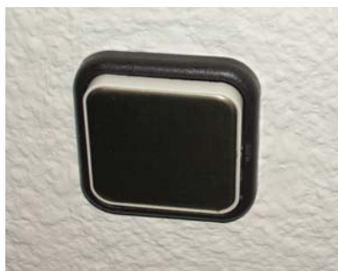
Figura 17 – Vista exterior de interruptor.
