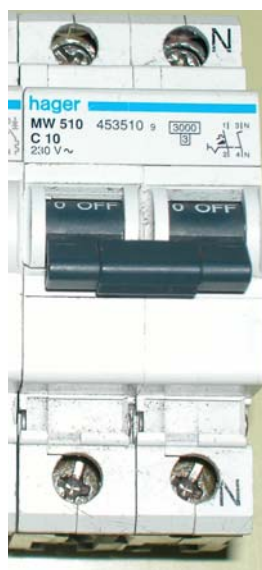
Figura 14 – Interruptor magnetotérmico bipolar.
