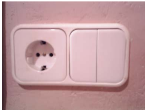
Figura 19 – Vista exterior de base de enchufe con toma de tierra y dos interruptores dentro del mismo conjunto.
