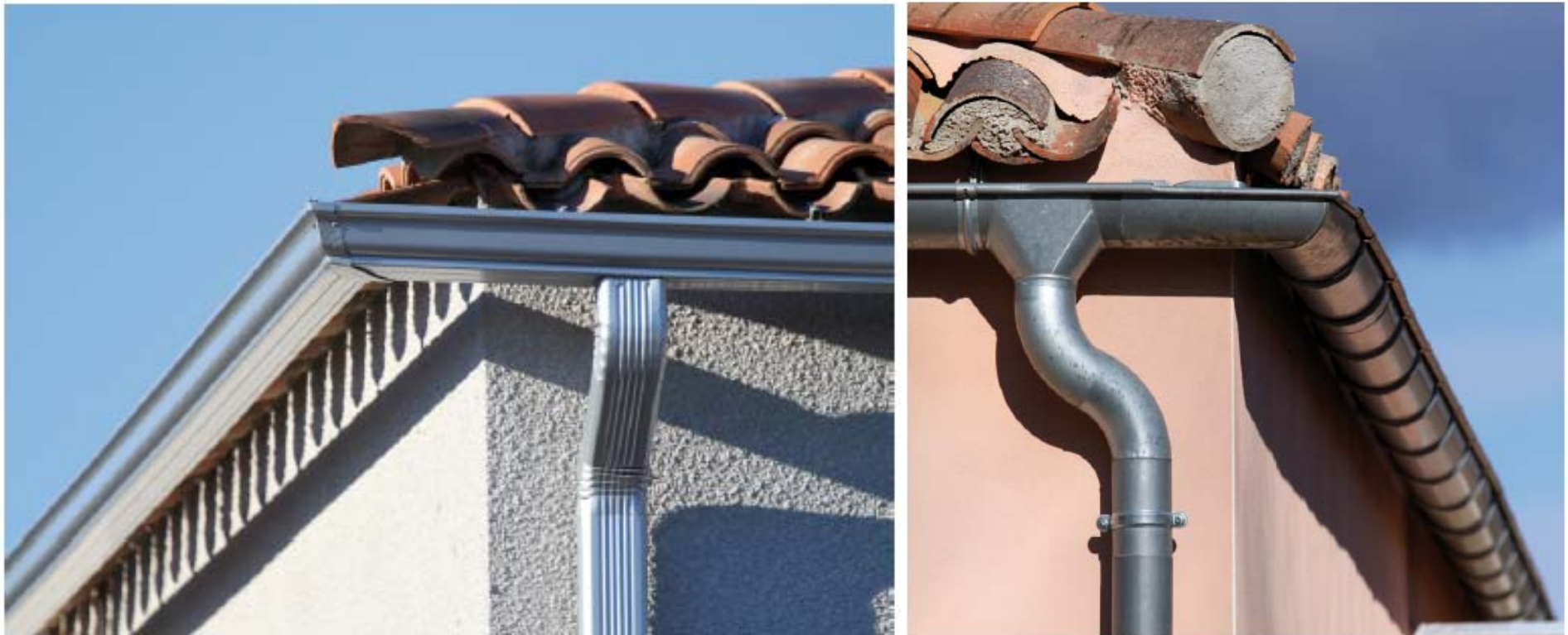
Figura 5.15. Detalle de canalones y bajantes fabricados con distintos materiales y formas.
