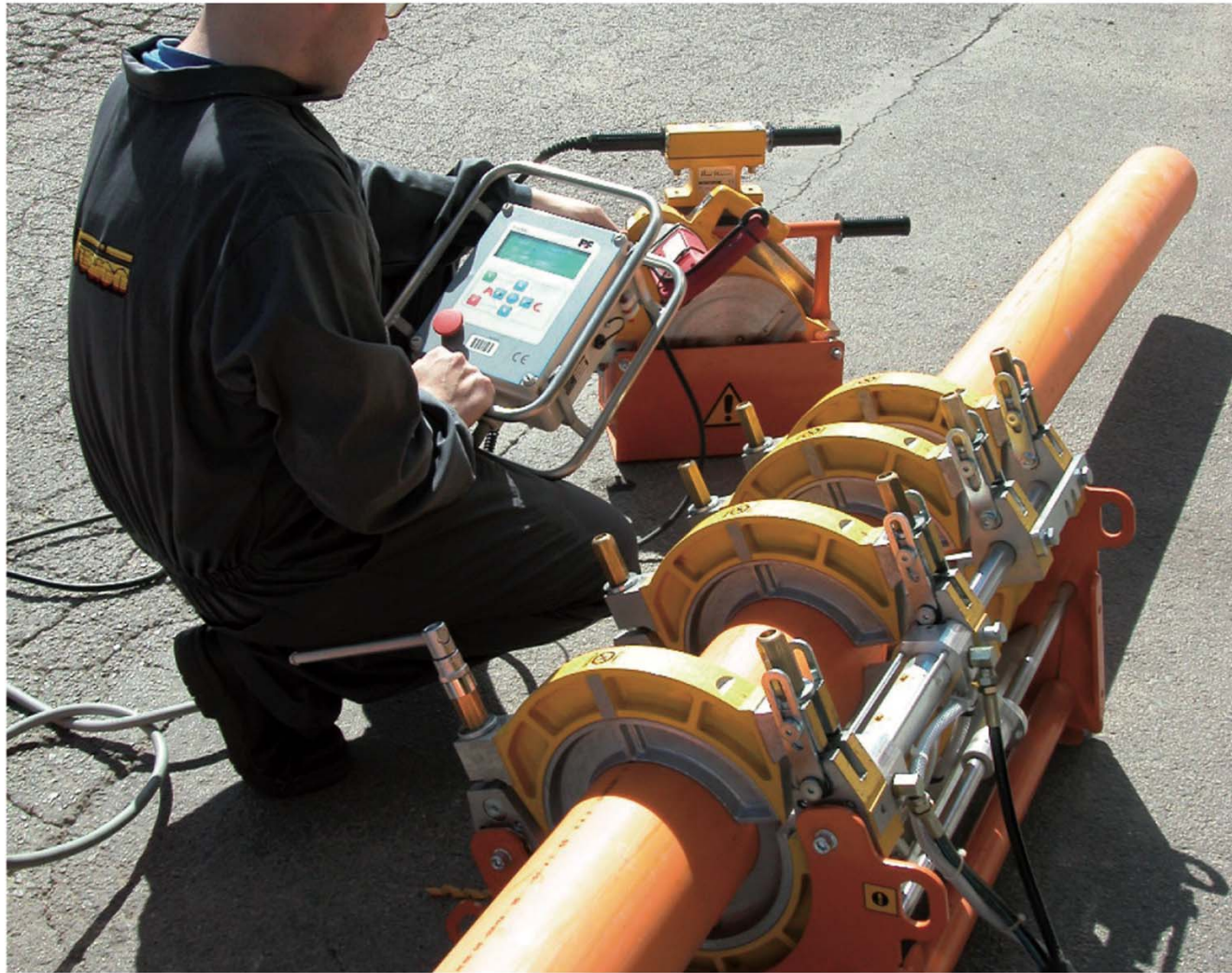
Figura 3.26. Soldadura a testa de tubería de polietileno. Cortesía de Plasson.
