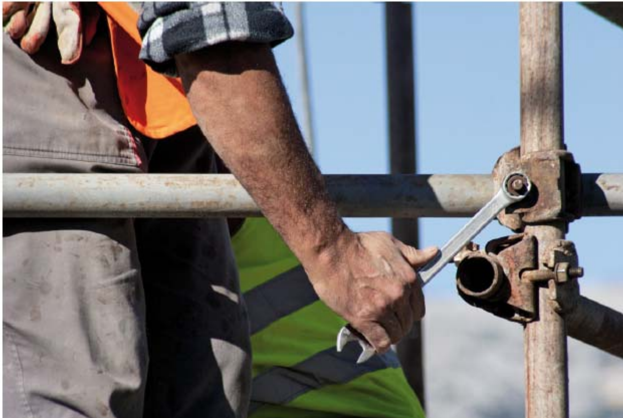
Figura 3.14. Montaje de andamios por personal cualificado.
