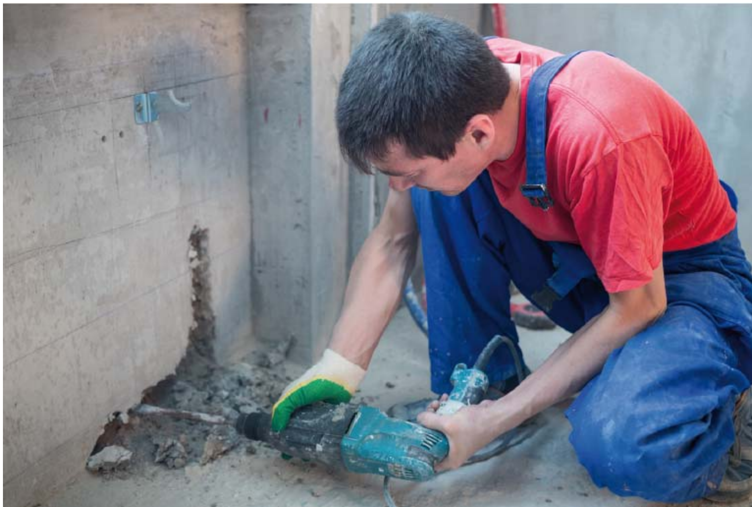
Figura 3.3. Apertura de hueco en el suelo y la pared con maquinaria eléctrica.
