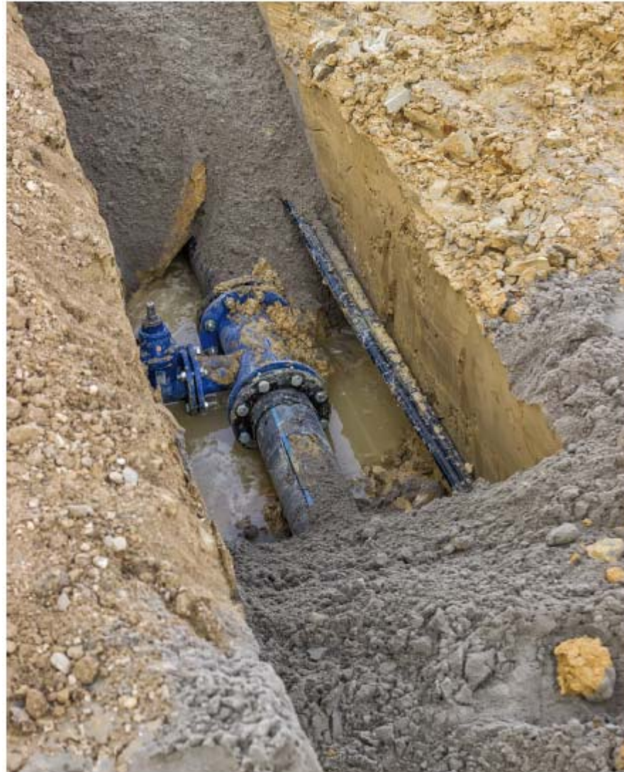
Figura 3.10. Zanja para tuberías en la vía pública.
