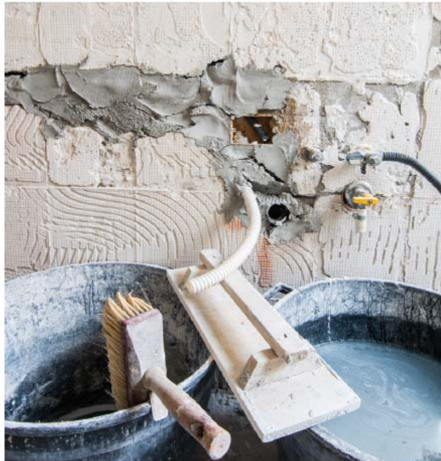
Figura 3.8. Tapado de tubos de forma provisional.
