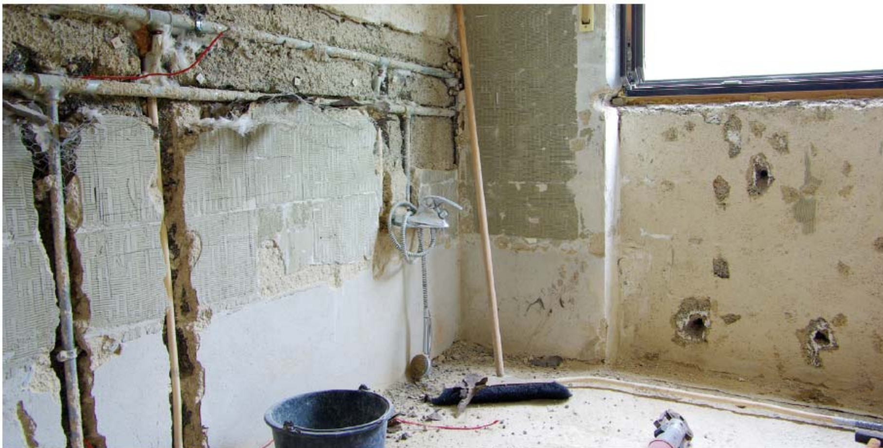
Figura 3.7. Instalación de tuberías empotradas en la pared para un futuro cuarto de baño.
