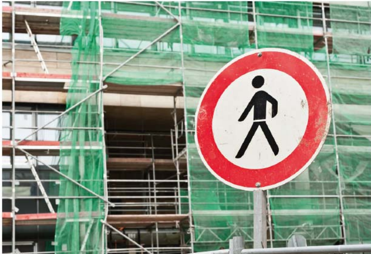
Figura 3.15. Señal de prohibido el paso en zona con andamios.
