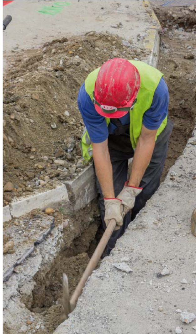
Figura 3.9. Apertura manual de una zanja para una tubería.
