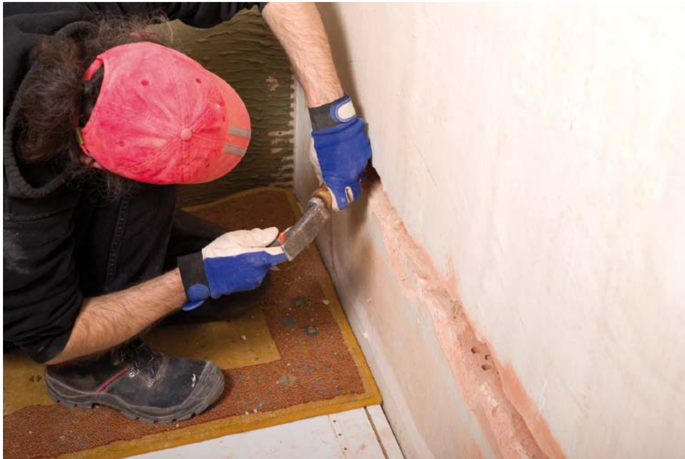
Figura 3.4. Apertura manual de una roza para la instalación de una tubería.
