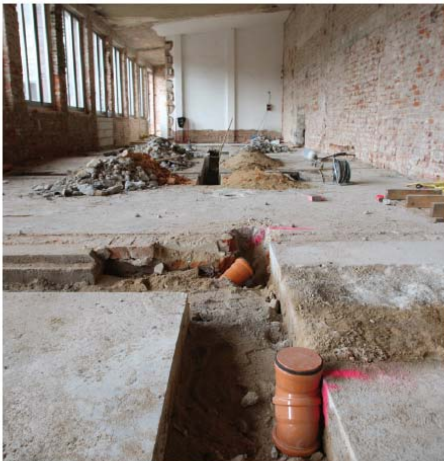
Figura 3.5. Apertura y marcaje en el suelo para tuberías de evacuación.
