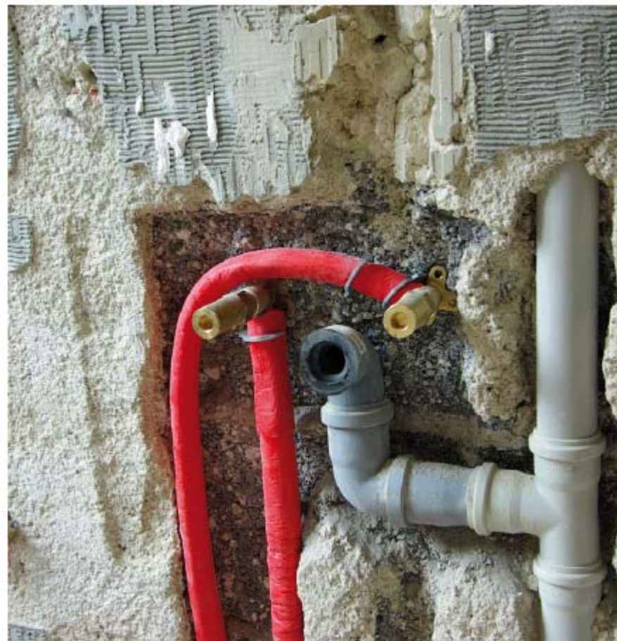
Figura 3.6. Proximidad de tuberías empotradas en la pared.
