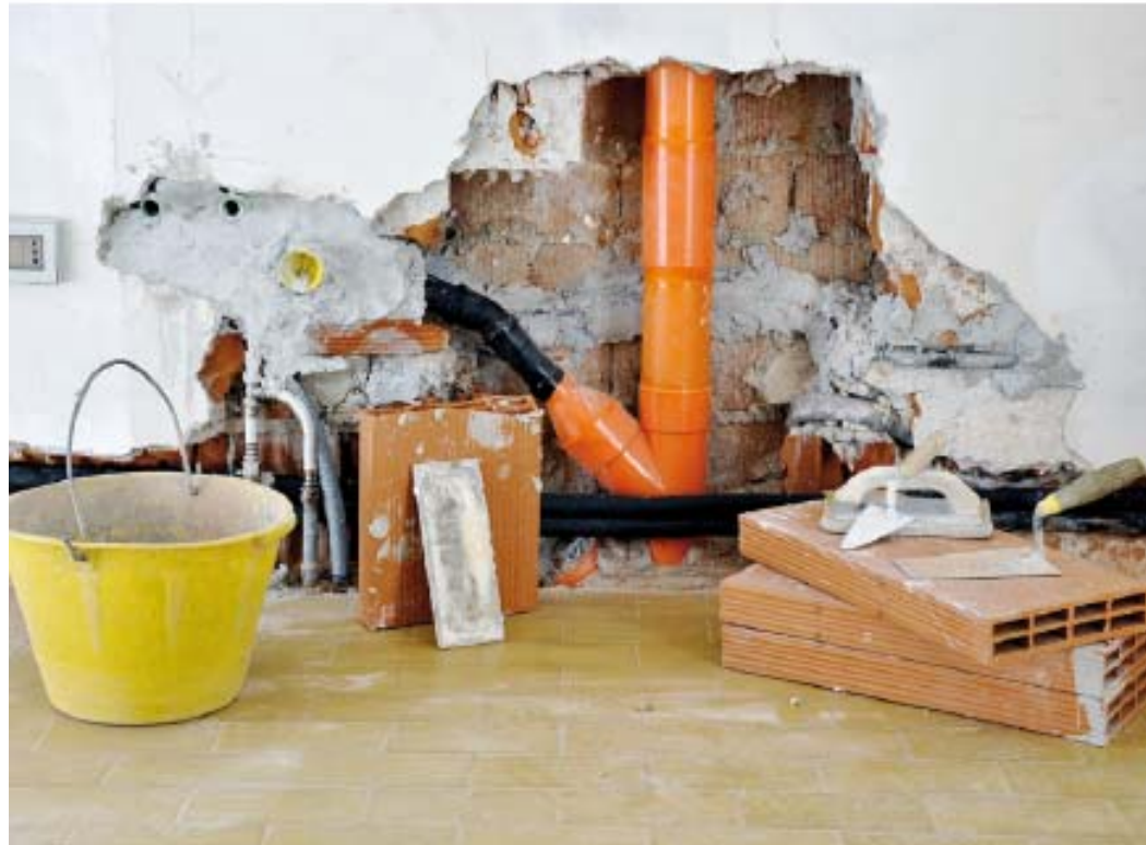
Figura 3.1. Apertura de hueco para la reparación de una tubería.
