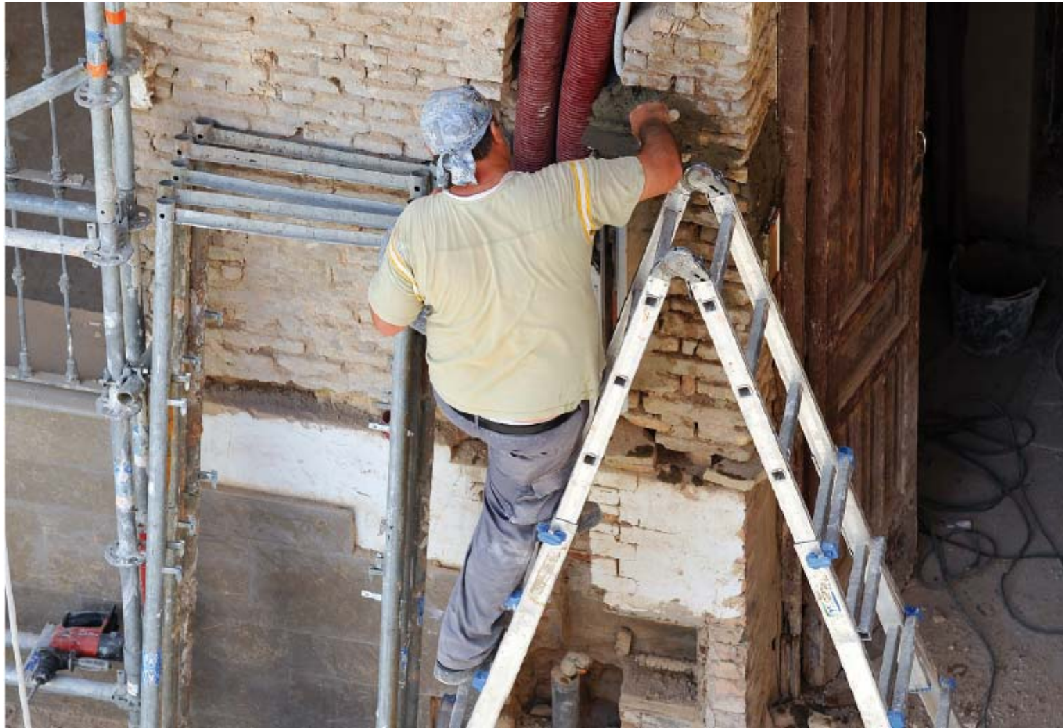
Figura 3.11. Trabajo con escalera a baja altura.
