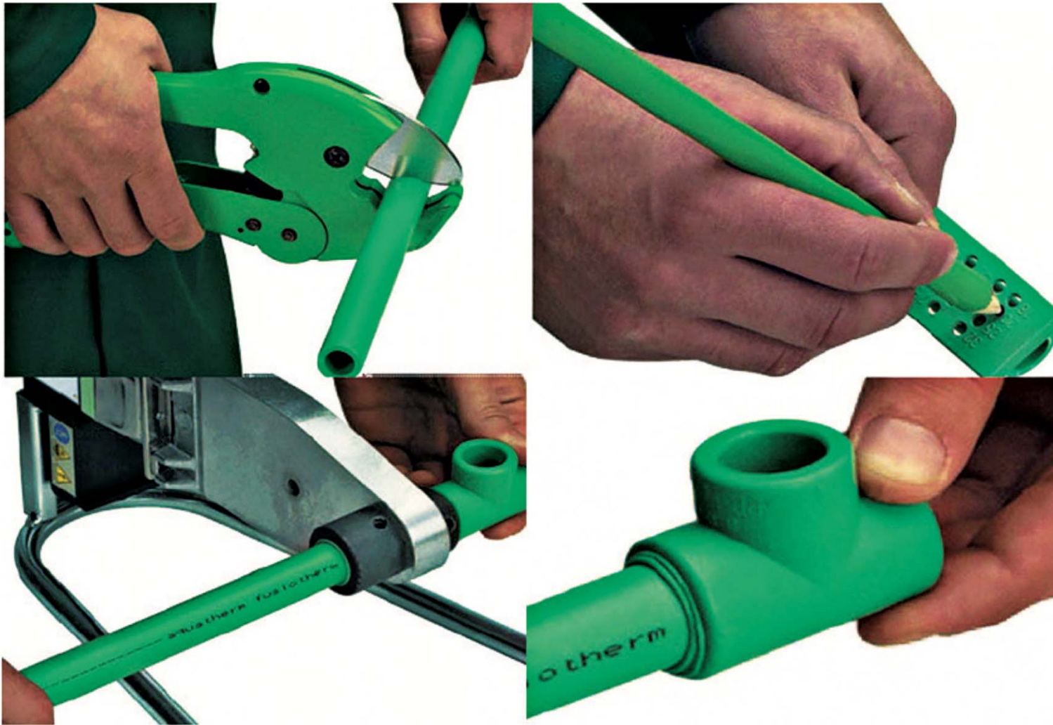
Figura 7.67. Proceso de unión de tubos de polipropileno por termofusión.
