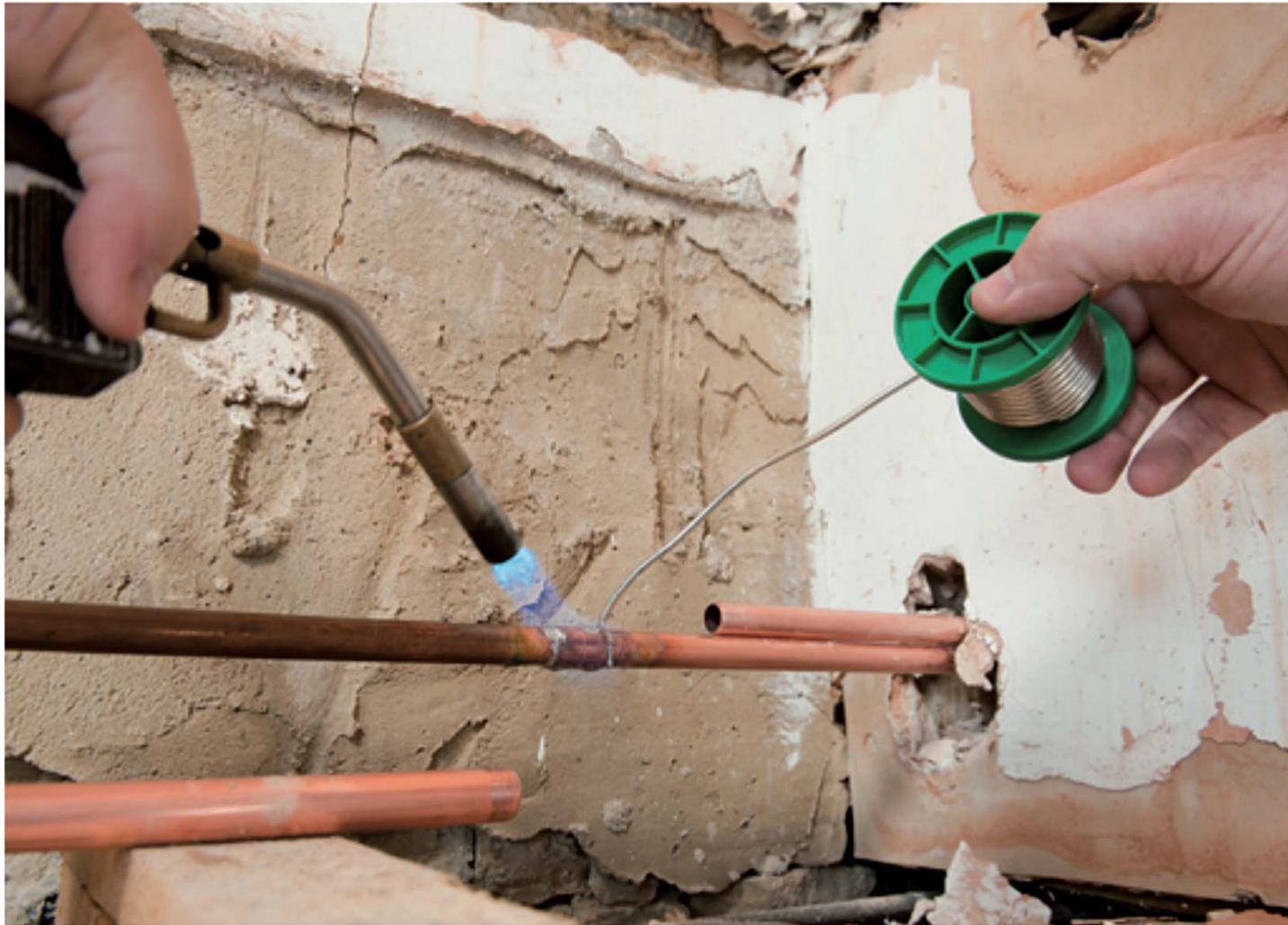
Figura 7.58. Soldadura con soplete de cartuchos desechables.
