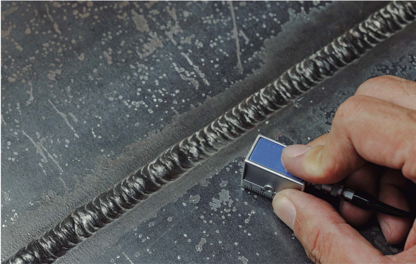
Figura 7.7. Comprobación de soldadura mediante ultrasonidos.
