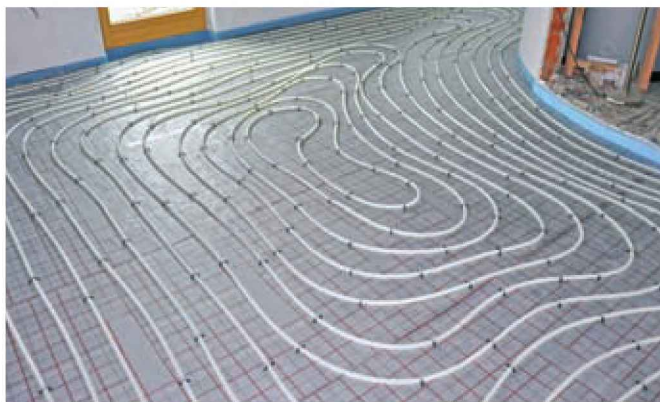
Figura 10.20. Instalación de suelo radiante
