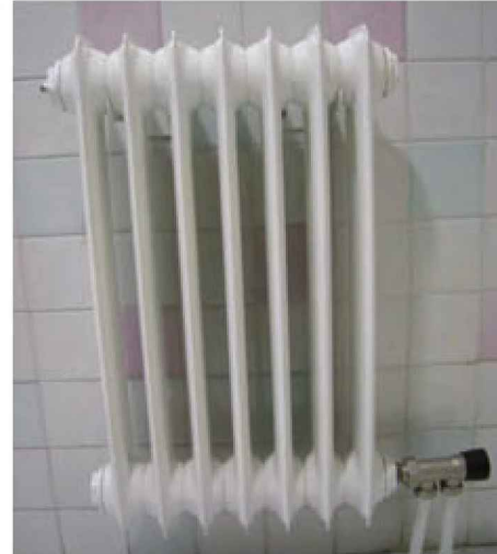
Figura 10.8. Radiador de hierro fundido
