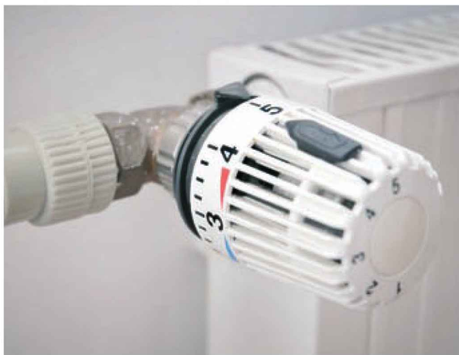
Figura 10.22. Válvula termostática de un radiador
