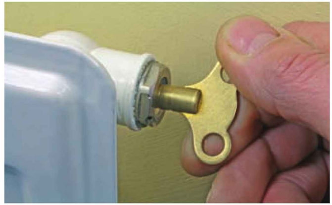
Figura 10.18. Purgadores manuales de radiador
