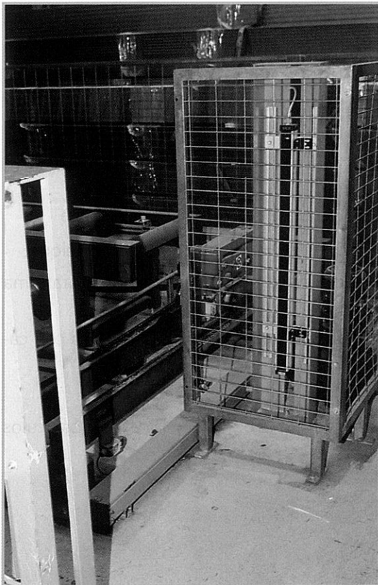
Fig. 5.4. Las medidas para prevenir contactos directos se basan en aislar o alejar las partes activas.
