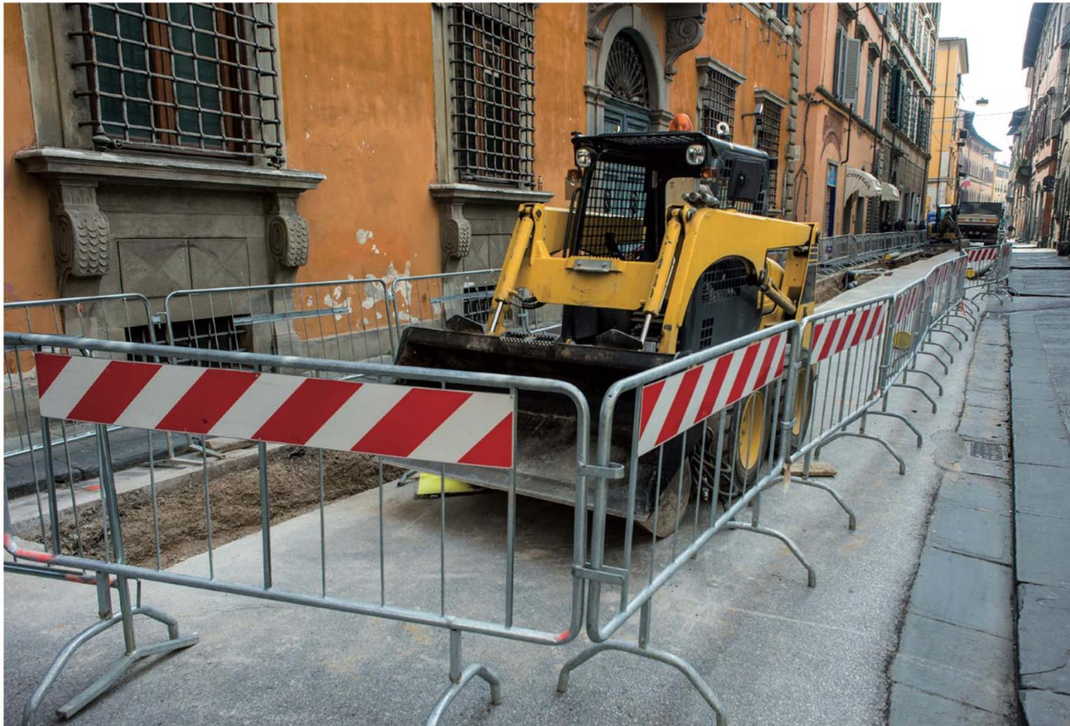
**Figura 8.34.** Señalización para indicar que hay una zanja.
